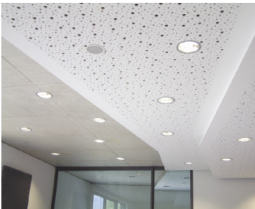
Eine Lochplatten-Akustikdecke minimiert Lärm.
